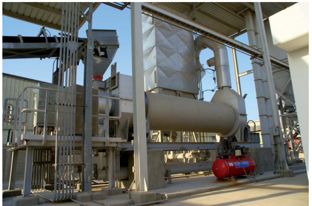
Afb. 1 Typische droogkoeltrommel voor kwartszand
